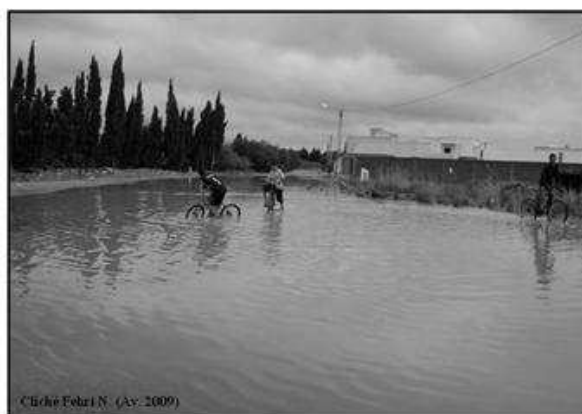
Photo 3. Oued Sebâa Ouidiane inondant une route qui le barre. A remarquer aussi la prolifération des constructions en zones inondables (Bou M'hal)
